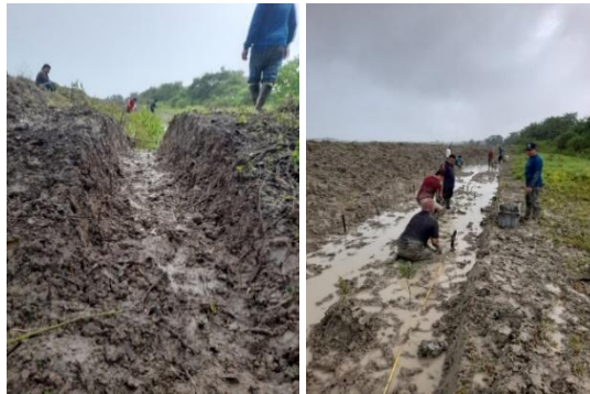
Figura 2. Mantenimiento y rehabilitación de canales en el área de restauración.
